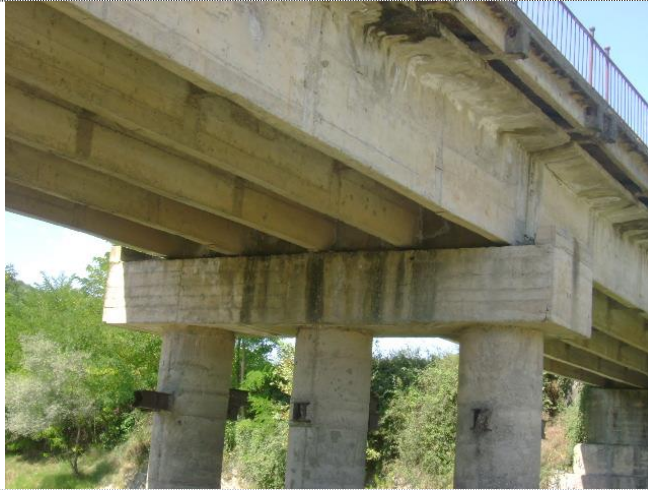
Figura 3-13 Pilat dhe trarët e urës
