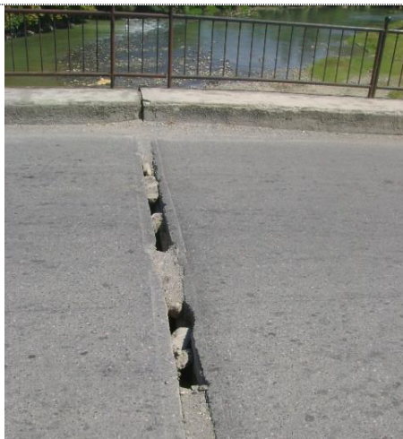
Figura 3-12 Fugat në urën ekzistuese
