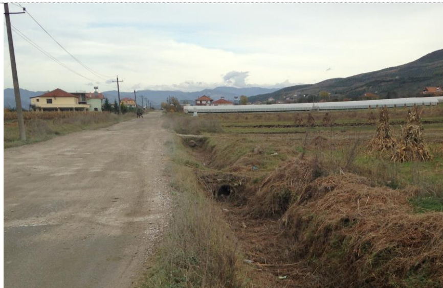
Figura 3-30 Segment i dëmtuar
