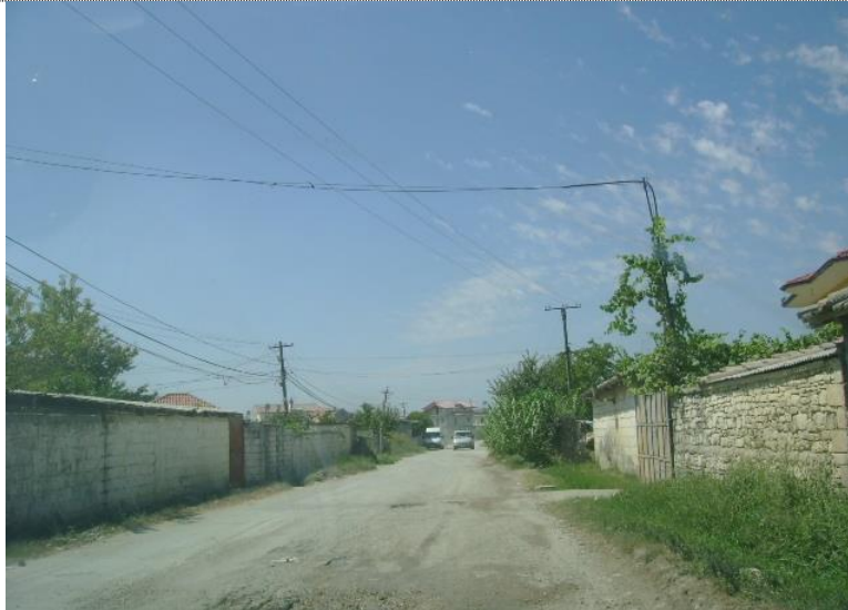
Figura 3-20 Segment i dëmtuar
