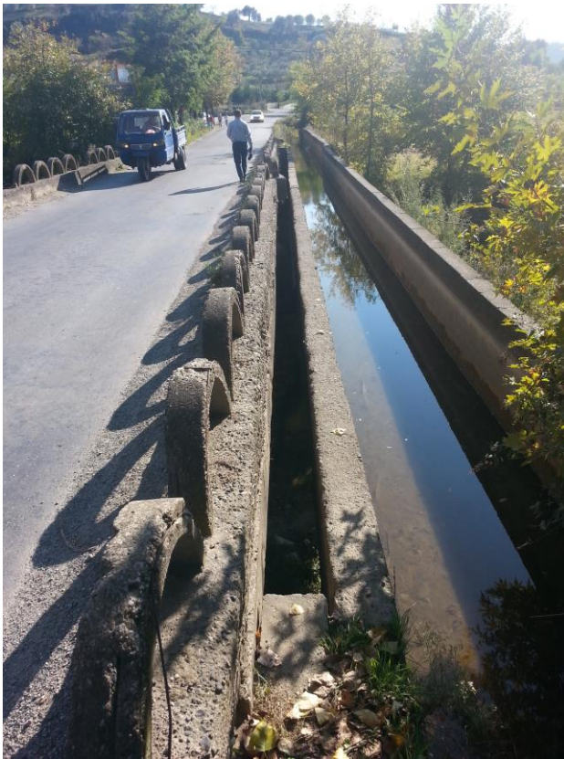
Figura 3-34 Kanali N. Panxhi në urën km 3+140
